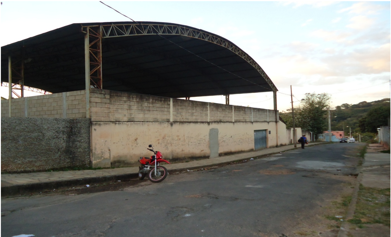
Figura 1- VISTA FACHADA FRONTAL
