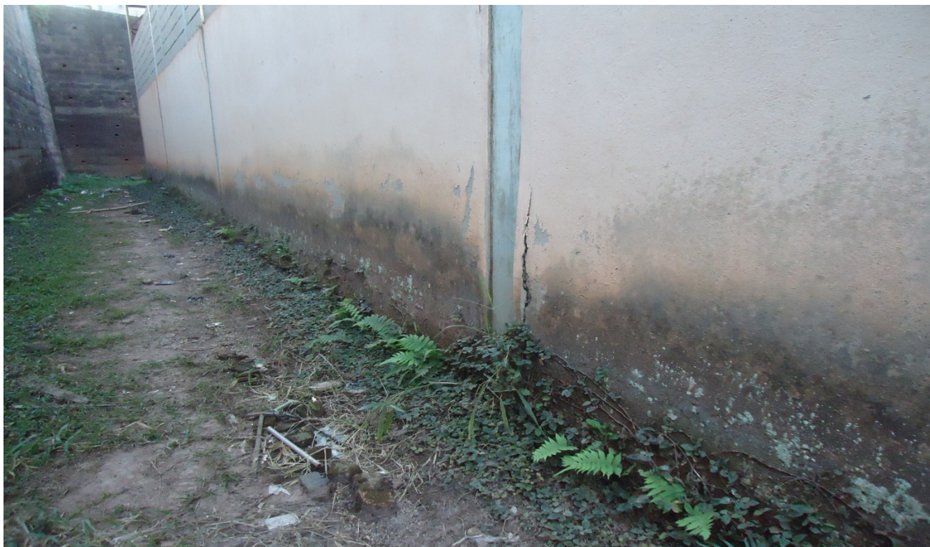
Figura 5: VISTA LATERAL - LADO MURO DE ARRIMO (SUBSTITUIÇÃO DO REVESTIMENTO EXTERNO H=1,20m)
