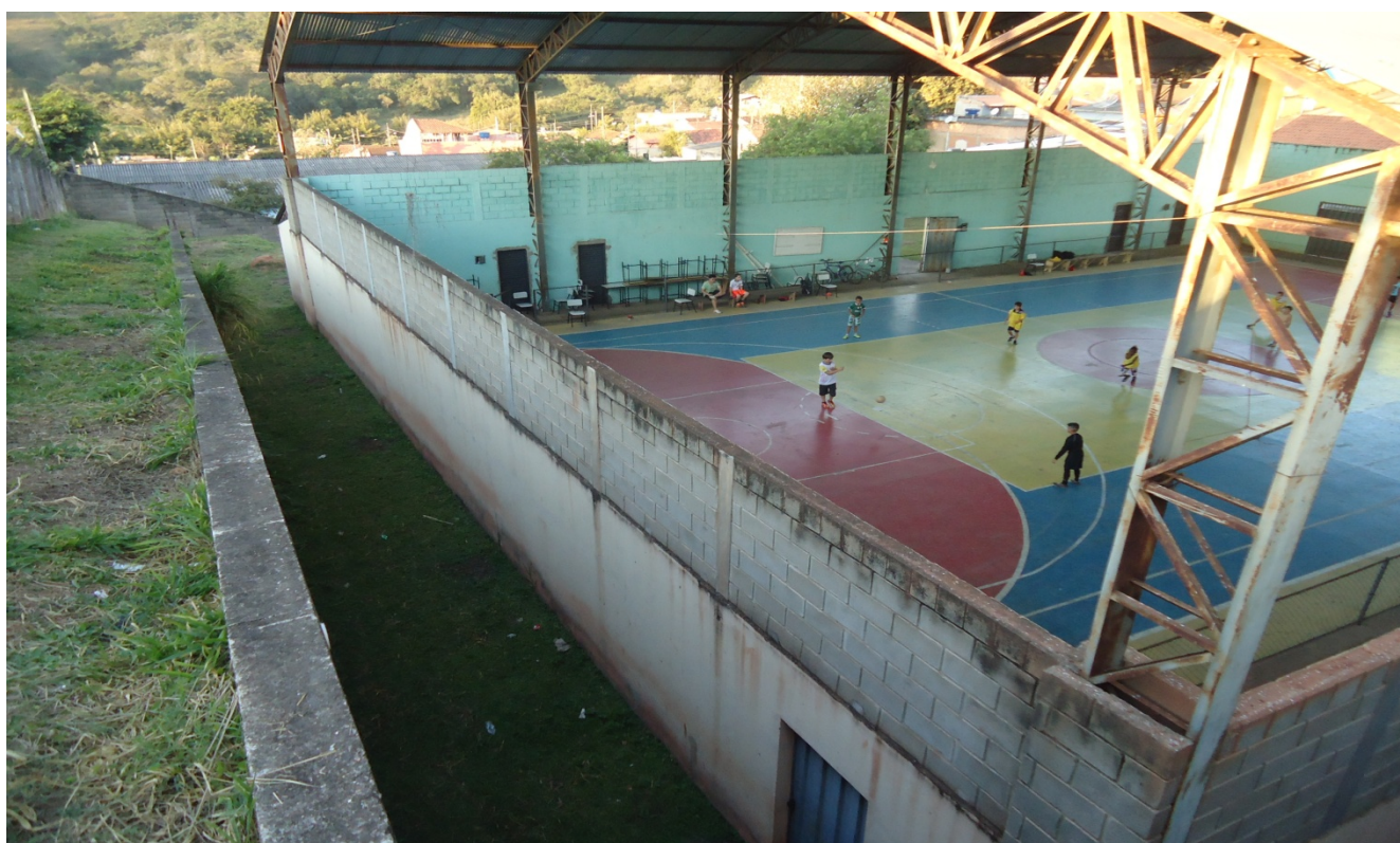
Figura 4: PAREDE DE FACHADA POSTERIOR
