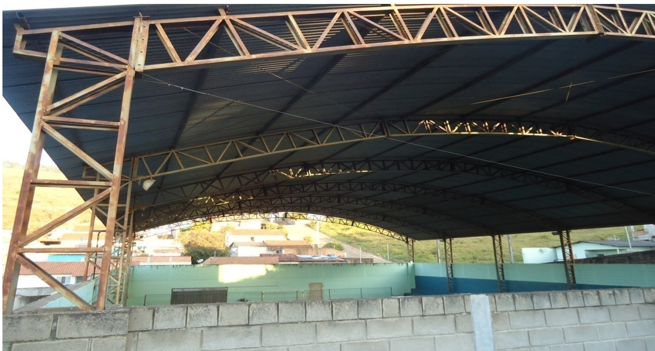
Figura 6: VISTA GERAL COBERTURA E PAREDES FECHAMENTO
