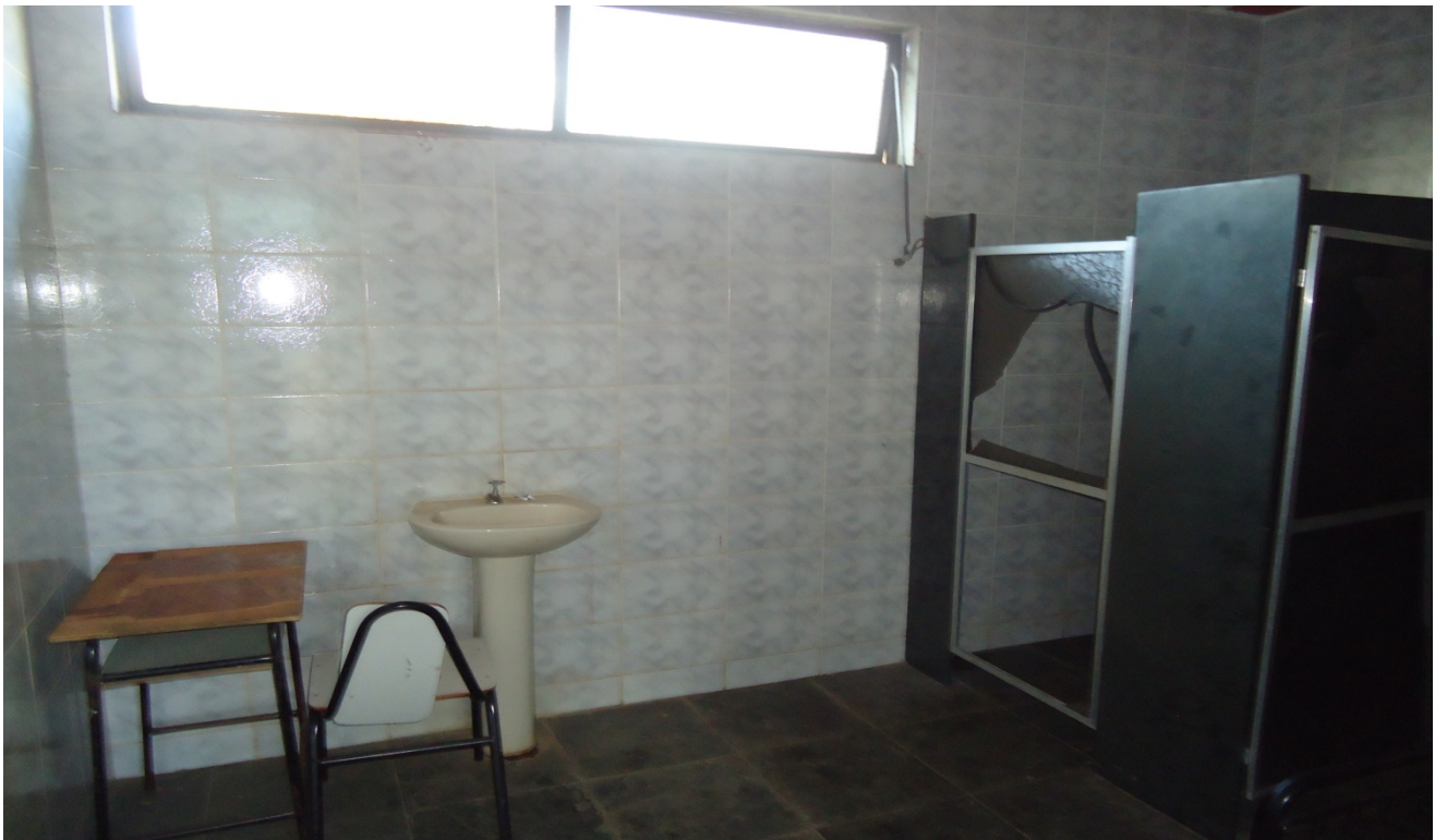
Figura 7: VISTA INTERNA VESTIÁRIO
