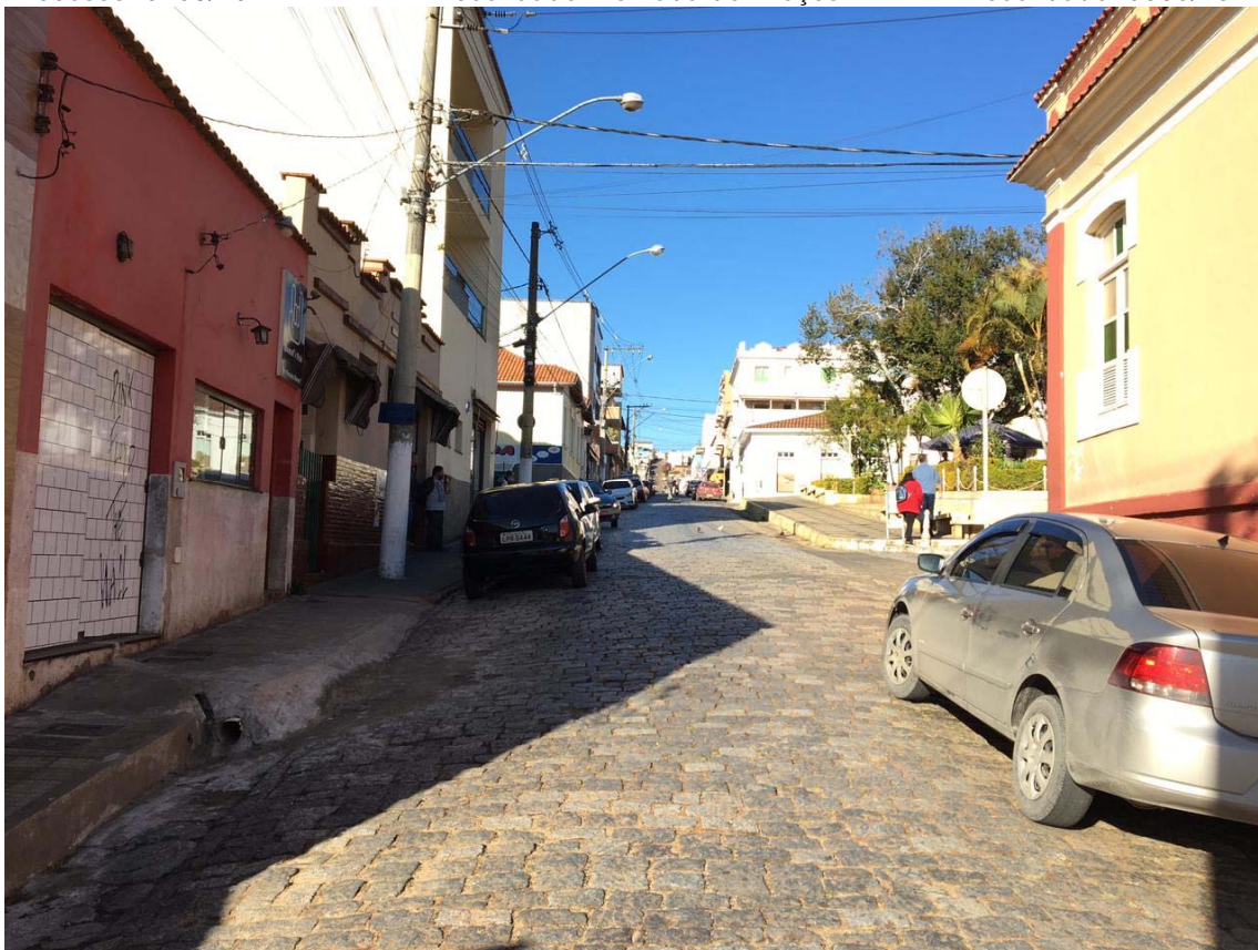
Foto 08 - Trecho Rua Pe. Inácio Kusk,16-07-2021
