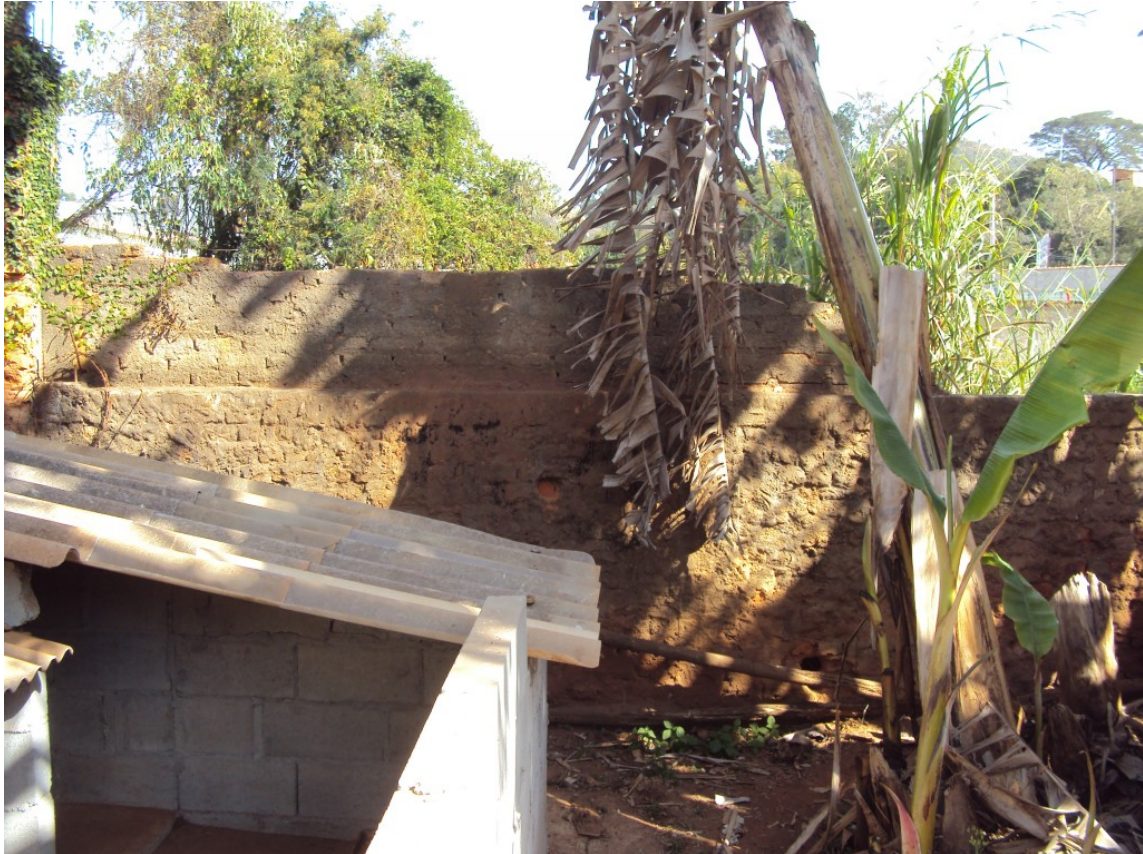
Foto 02 - Muro Confrontante Ribeirão, 16-07-2021
